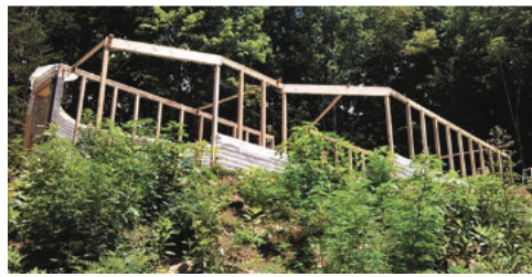
アースバッグハウスの建設段階での様子。家を部分的に埋めることで、熱を吸収・蓄積する能力が向上する。
