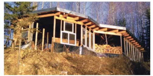
アースバッグハウスの建設段階での様子。家を部分的に埋めることで、熱を吸収・蓄積する能力が向上する。
